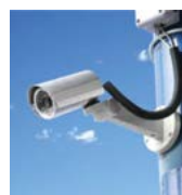
Installation de la vidéo-surveillance au bord du Beuvron et à la Croûte
