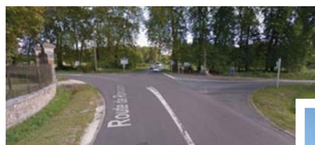
Aménagement du carrefour de La Chauvellerie
