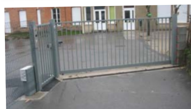
Installation d'un nouveau portail automatisé et sécurisé à l'école
